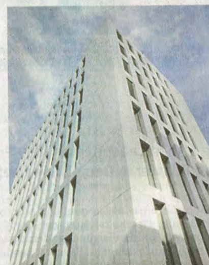
In eine Außenhaut aus Aluminium hüllt sich das Holzhochhaus „LCT One“. Über zwei seiner Stockwerke erstreckt sich eine Ausstellung, die sich mit der Bauweise des LCT One und dem Thema Nachhaltigkeit befasst. FOTO: HERMANN KAUFMANN/CREE GMBH
